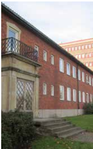
Täby kommunhus, tillbyggnaden i bakgrunden planeras att rivas.
