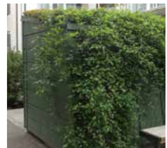
Servicebyggnader med grönska på fasad och tak
